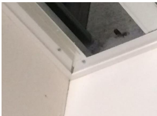
写真1. 見切材を先行して取付
